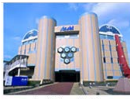
写真：博多工場入口
